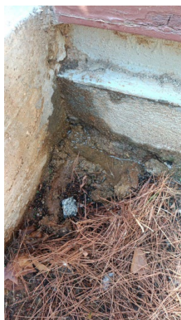
Imatge 4-7 possible fuga d'aigua o del desaigüe.
